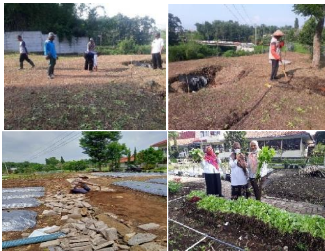
Gambar 8.4. Pengolahan lahan dan pembuatan jalan serta proses dan hasil pemasangan paving block
