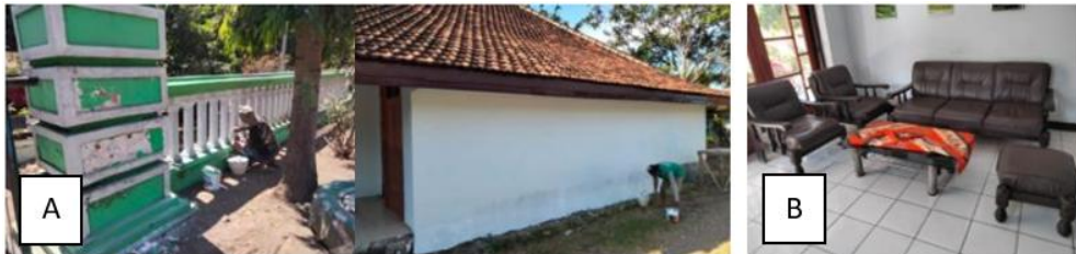
Gambar 31. Pengecatan dinding dan Pagar Kantor (A) dan Perbaikan kursi tamu (B).
