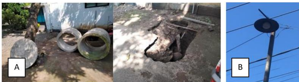
Gambar 30. Perbaikan Septic Tank (A) dan Kabel-Lampu Penerangan (B).
