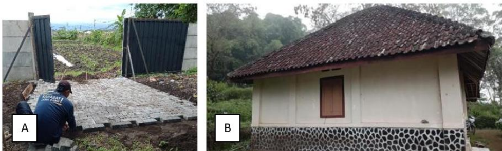
Gambar 23. Pemeliharaan Bangunan Pagar Precasting Emplasemen (A) dan Gedung Kantor Lahan Pengujian Coban rondo-Pujon (B).
