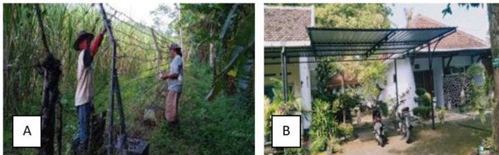
Gambar 32. Perbaikan Pagar Kawat Duri (A) dan Atap Kanopi Parkir (B).
