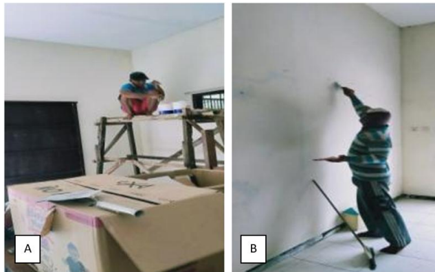
Gambar 33. Pengecatan Langit-Langit dan Dinding Kantor.
