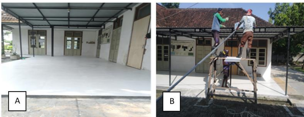
Gambar 26. Perbaikan Lantai Teras Kantor Seleksionis (A) dan Pemasangan Rangka Kanopi Teras Kantor (B).
